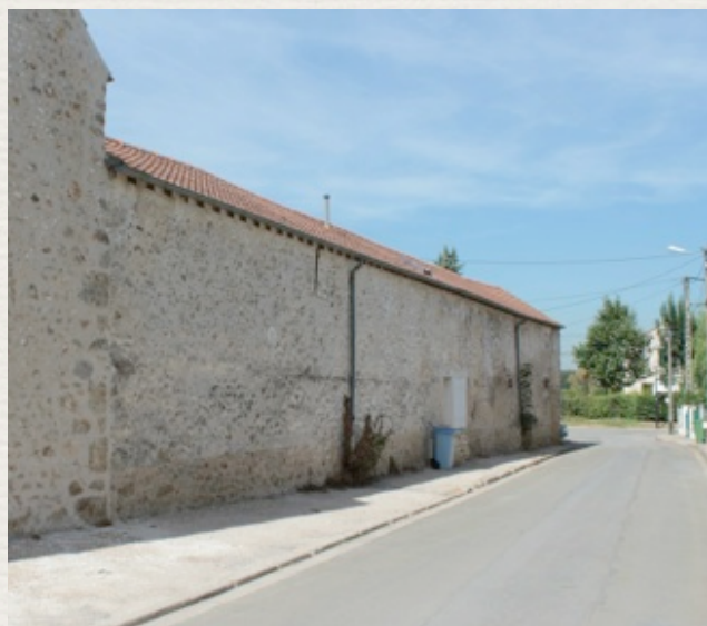
Zone 3 vue extérieure
