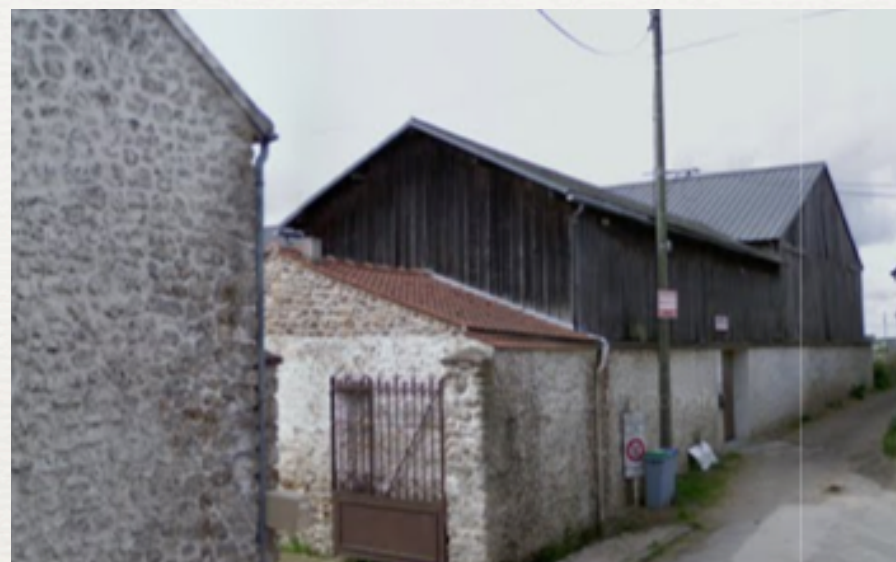
Zone 2 vue extérieure
